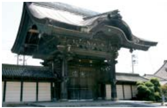
工事が始まり扉が閉められた唐門
